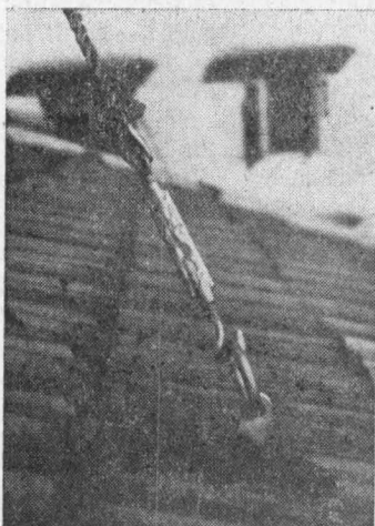
FOTO 2 — Os esticadores dos tirantes deverão receber a massa de vedação 3M para proteger da ferrugem as roscas dos parafusos.
