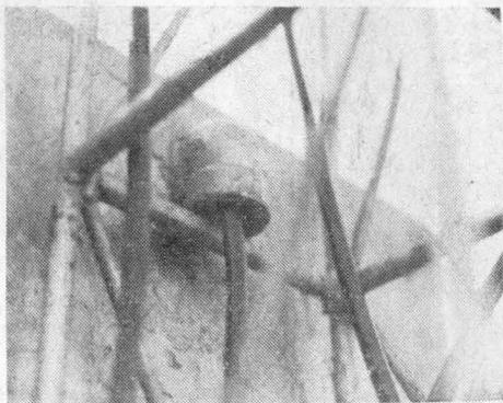
FOTO IV — O Joelho que dá passagem para o cabo coaxial da antena.
