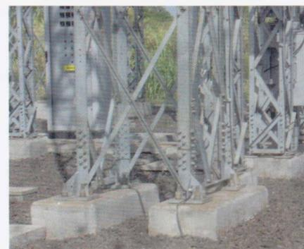
Figura 2 - Aterramento de uma torre do barramento de uma subestação.
