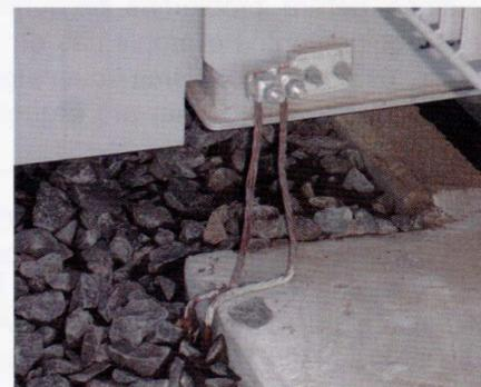
Figura 1 - Aterramento da carcaça de um transformador em usina hidrelétrica
