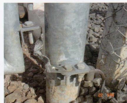
Figura 3 - Aterramento de um portão metálico em uma subestação. Note o cabo flexível que faz a ligação do moirão ao portão.
