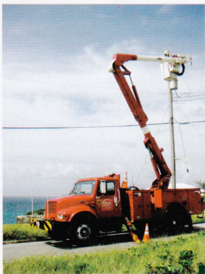
Manutenção do poste problemático
